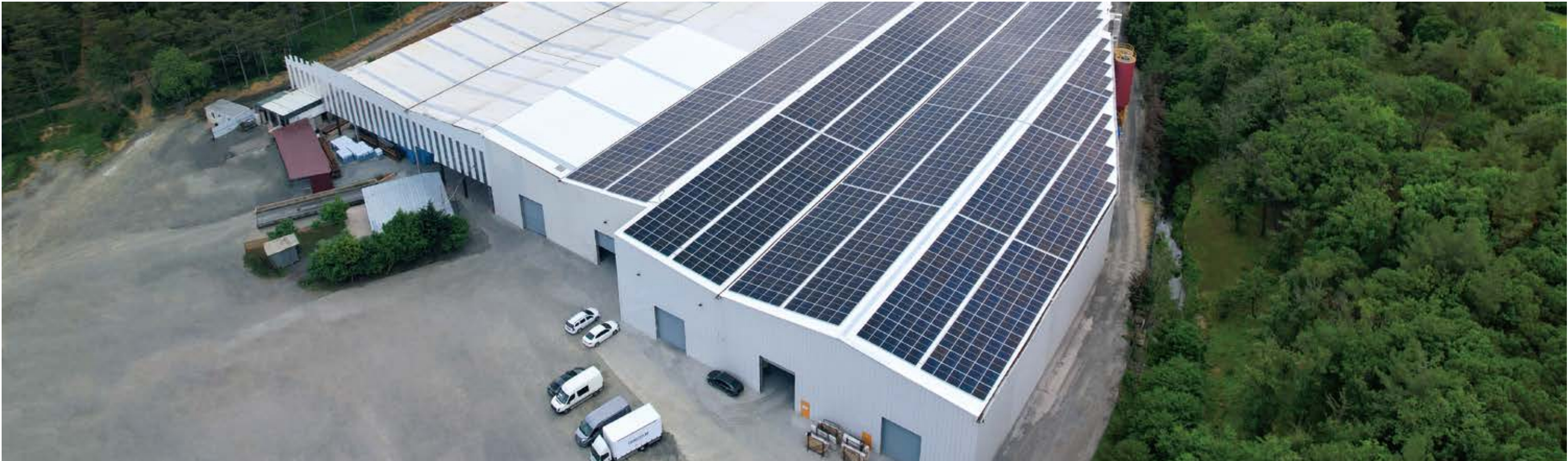
04 Energiekostensenkung in Mineralwasser-Herstellung Türkei, 900kW KSG-120CL-M0
