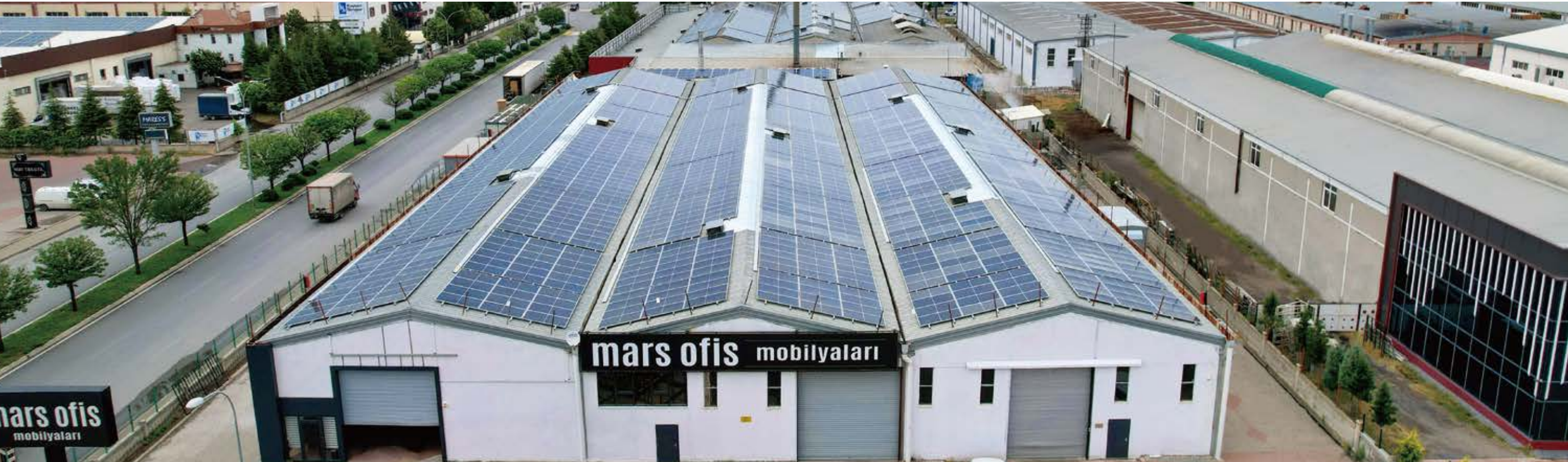
01 Grüne Revolution in einer Kunststofffabrikation in der Türkei, 900 kW KSG-120CL-M0
